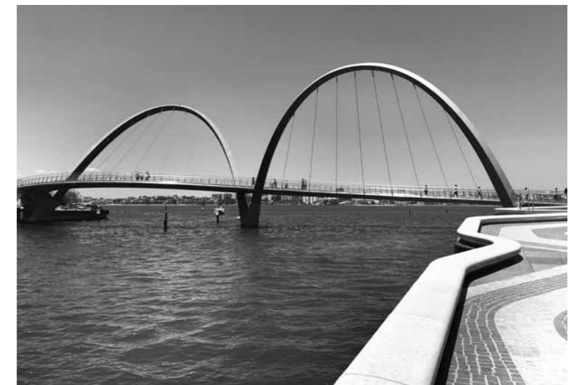
耐用年数100年とした二相系ステンレス鋼製歩道橋
