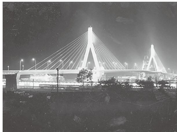
(写真-1) 3径間連続PC斜張橋 青森ベイブリッジ
