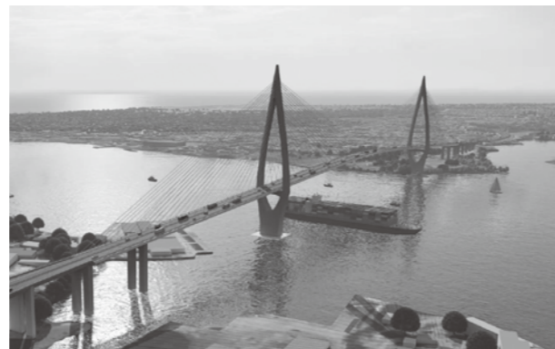
図-2 モンバサ港合成斜張橋(スパン660m)、完成予想図 出展:国際協力機構、ケニア国モンバサゲートブリッジ建設事業詳細設計業務
