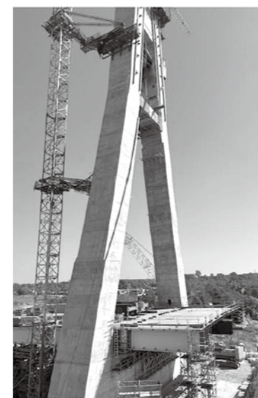
施工中のミャンマーザタピン橋 (提供: 植田信一氏)
