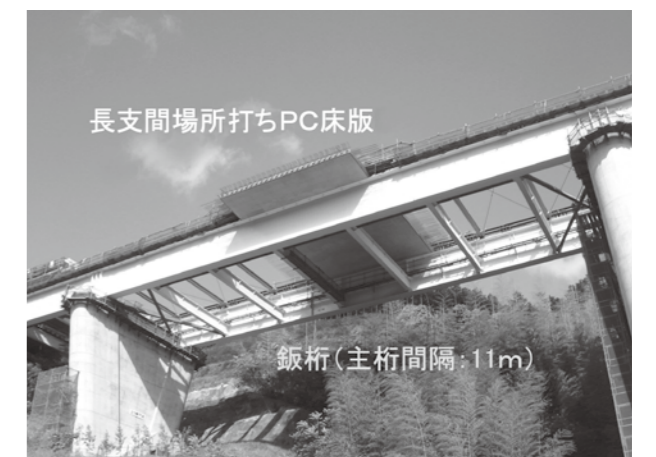
新東名高速道路葦科川橋の鉸桁PC床版の施工状況
