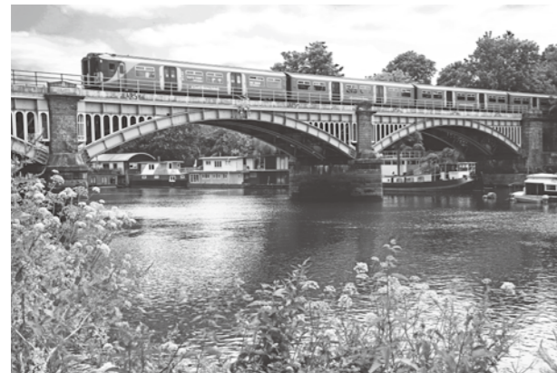
(写真-1)リッチモンド鉄道橋(イギリス・リッチモンド)
