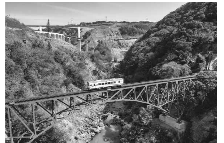
熊本地震復旧状況調査で見学を実施した第一白川橋梁
