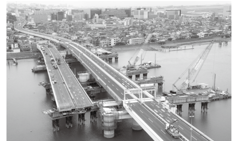
高速大師橋の架け替え状況
