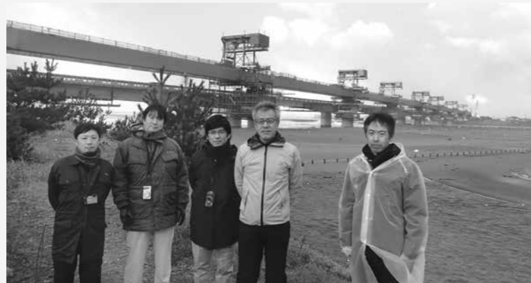
厳冬期の手取川橋の架替工事現場にて
