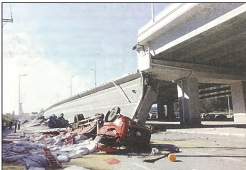
写真 3.2.1 崩壊の状態 6)
