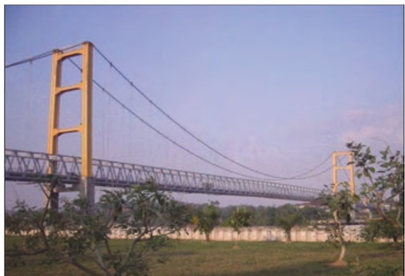
写真 3.2.2 崩壊前のクタイ・カルタネガラ橋 7)
