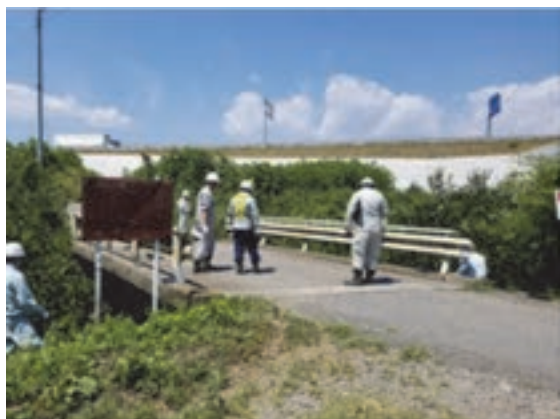
(b) 小規模鋼橋 2
