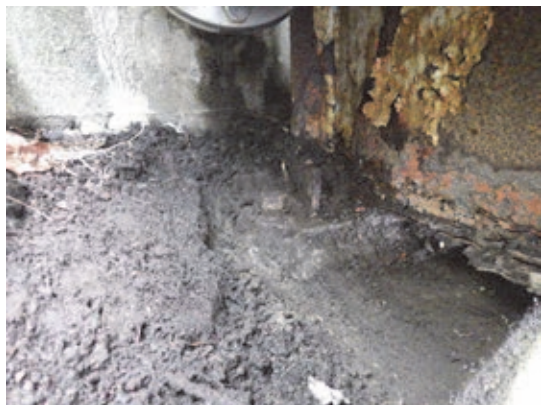
写真 4.3.6 G 橋における主桁端部
