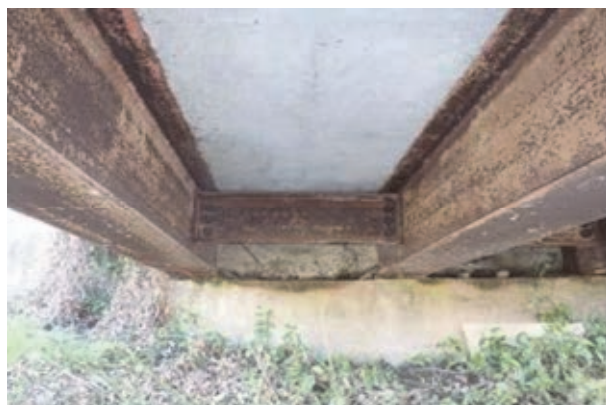
写真 4.3.3 I 橋における主桁支間部
