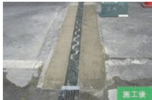
(d) 伸縮装置の取替 (施工後)
