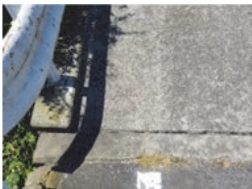
(a) 伸縮装置 1
