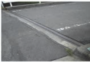
※桁端部伸縮装置後打ち コンクリート部舗装写真-2
