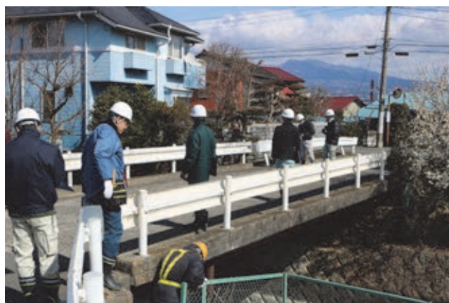
写真 4.4.3 現地調査の様子
