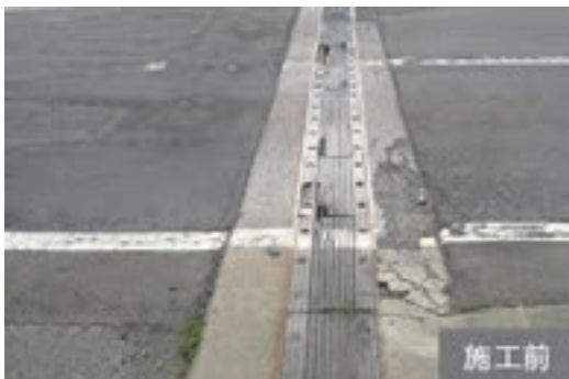
(c) 伸縮装置の取替 (施工前)
