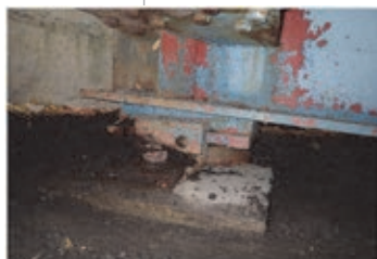
※桁端部支承部写真
