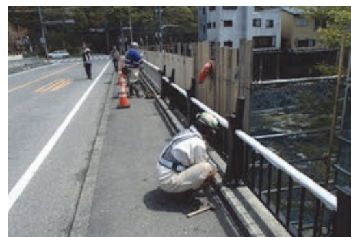
(h) 高欄の取替
