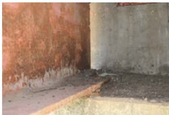
(b) 土砂、さびの堆積
