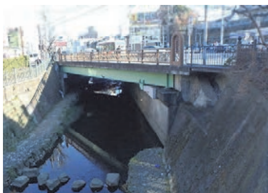
(a) 対象の橋梁の全景
