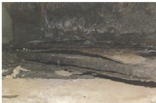
写真 4.3.5 F 橋における主桁端部
