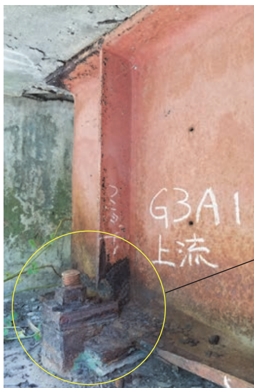
(a) 支点部全体
