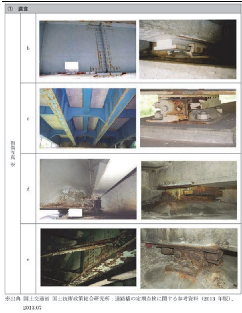
図 4.4.3 評価指標パターン②（腐食） 2)
