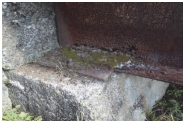
写真 4.3.2 I 橋における主桁端部
