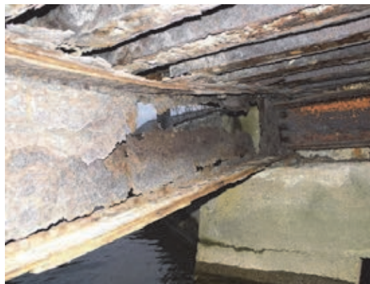
写真 4.3.7 H 橋における主桁端部
