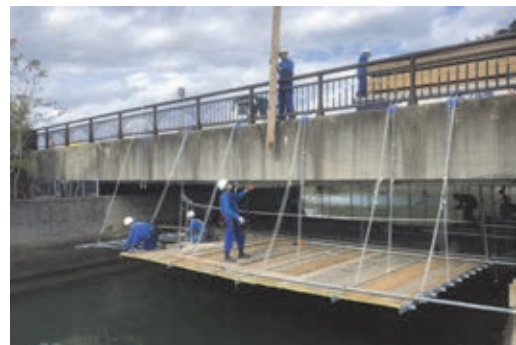
(f) 足場の施工
