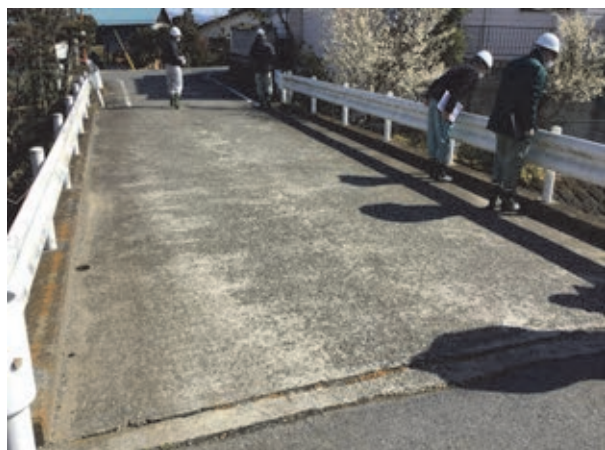
(a) 橋面上側の状況
