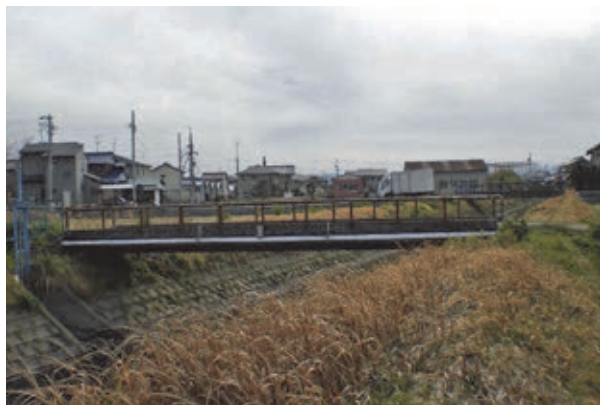
写真 4.3.1 I 橋の全景
