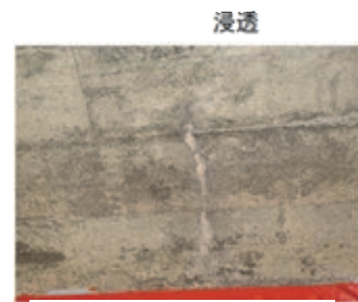
※支間部床版下側写真
