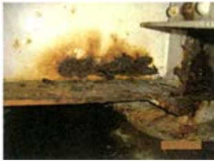
(a) 桁端部腹板 (その 1)
