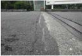
※桁端部伸縮装置後打ち コンクリート部舗装写真-1
