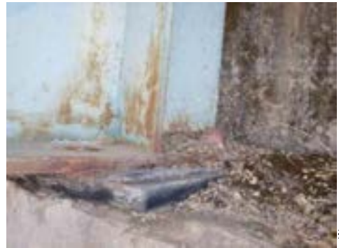
<セットボルトの抜け、土砂詰まり>
