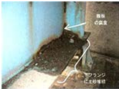
(a) 桁端下フランジ上面の状態
