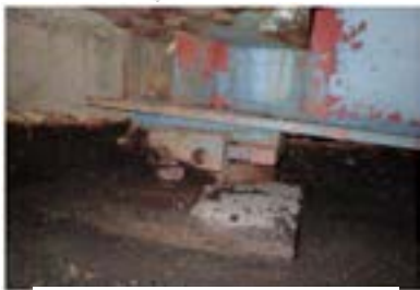
※桁端部支承部写真
