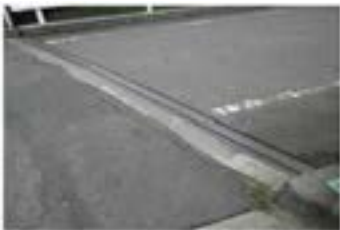
※桁端部伸縮装置後打ち コンクリート部舗装写真-2
