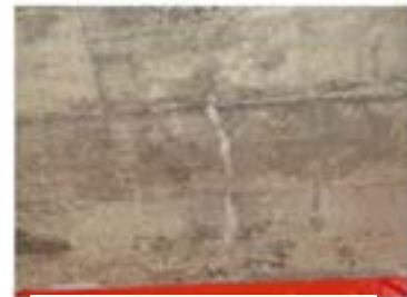
※支間部床版下側写真
