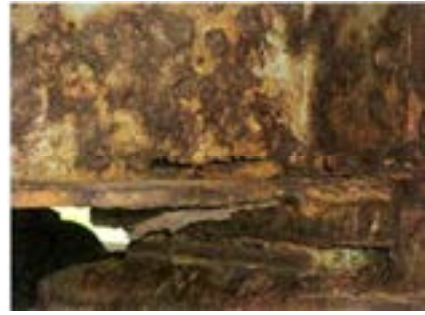
(b) 桁端部腹板 (その 2)
