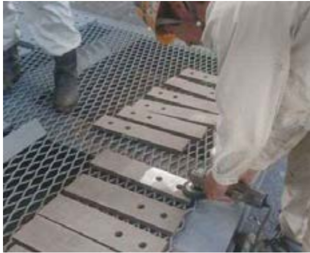
図 3-2-2 グラインダーによる接触面 g の施工状況
