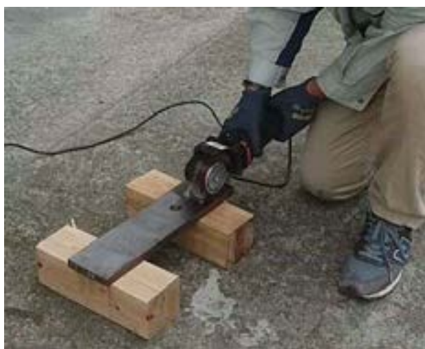
図 3-2-1 縦回転式動力工具による接触面 v の施工状況
