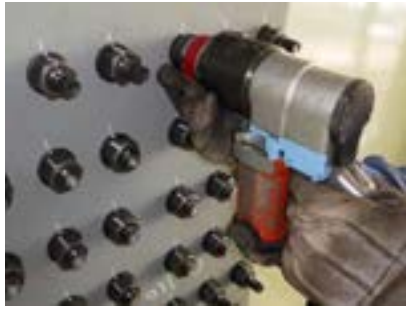
図 4-1-4 シャーレンチによる締付け
