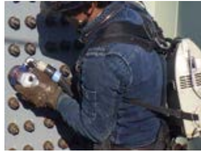
図 4-1-5 ピンテール仕上げ専用機
