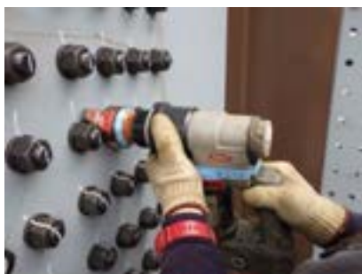
図 4-1-6 ナットランナーによる締付け 図 4-1-7 トルクレンチによるトルク確認
