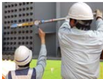
図 4-1-6 ナットランナーによる締付け 図 4-1-7 トルクレンチによるトルク確認
