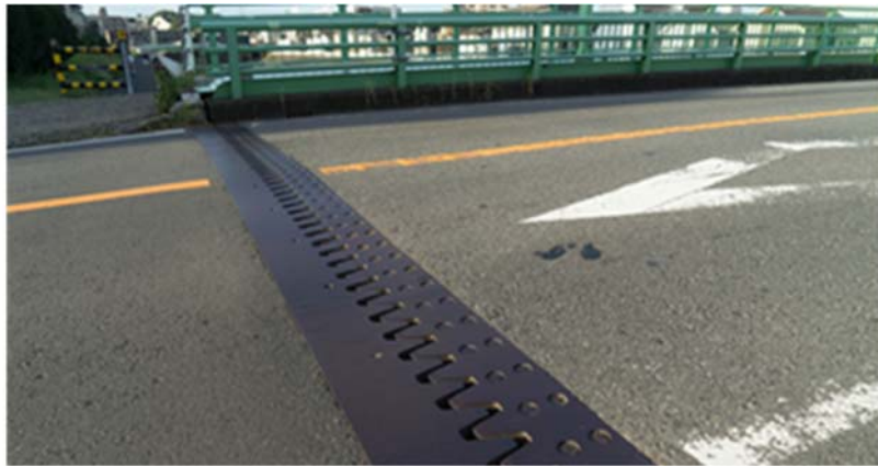
図 3-1-5 対象橋梁のエキスパンジョイントの状況
