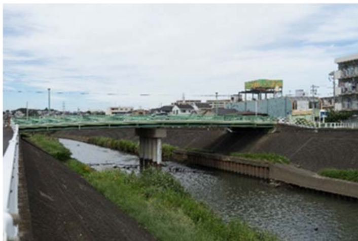
図 3-1-4 対象橋梁の外観写真
