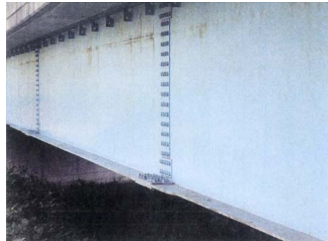
劣化の遅い部位 (桁中間部の腐食事例)
