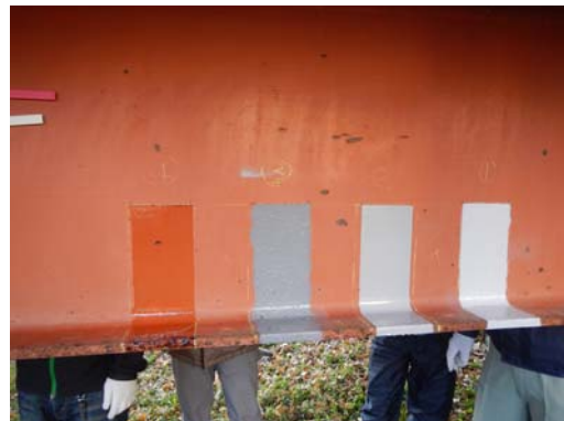
図 4-9 4種類の塗料の吹付け後の状態
