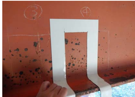
図 4-7 マグネットシート設置
