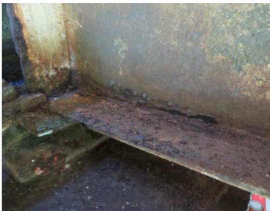
a) 桁端部の腐食事例
