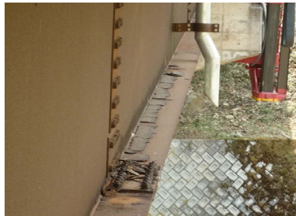
b) 排水装置不備による腐食事例
