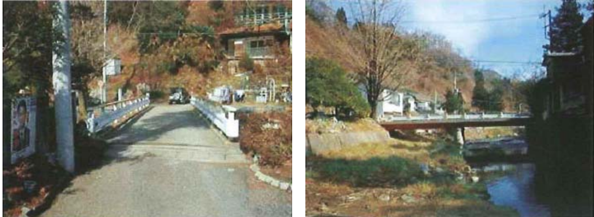
図 4-2 対象橋梁の全景写真
