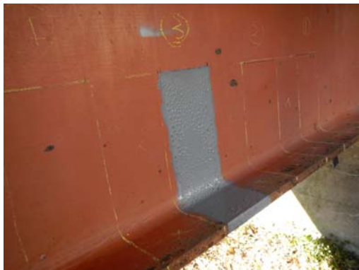
図 4-8 吹付け後の状態
