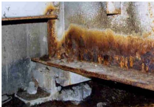
劣化の早い部位 (桁端部の腐食事例)
