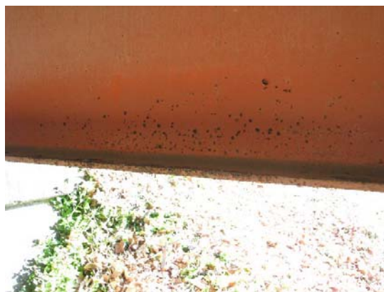
図 4-4 主桁 Mg0202 の損傷写真 (試験施工対象範囲)
