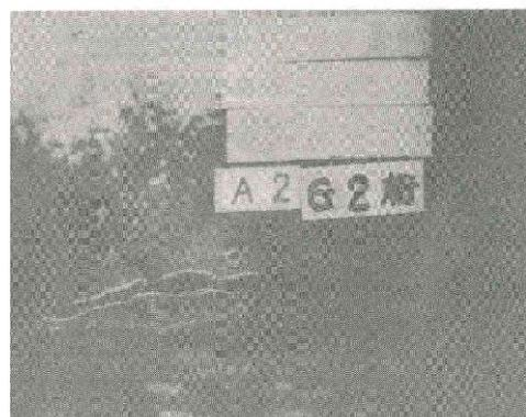
主桁端部の腐食損傷状況
