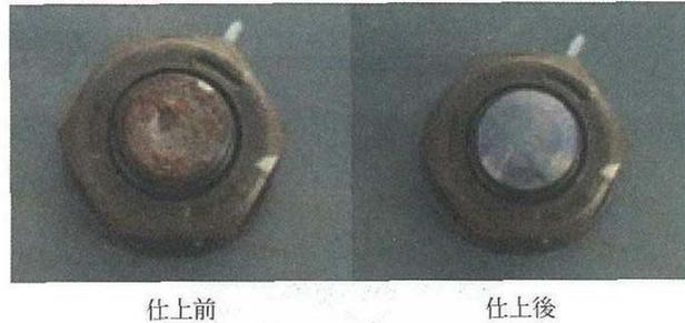
写真-Ⅱ.3.1 専用加工機によるピンテール跡の仕上げの例
