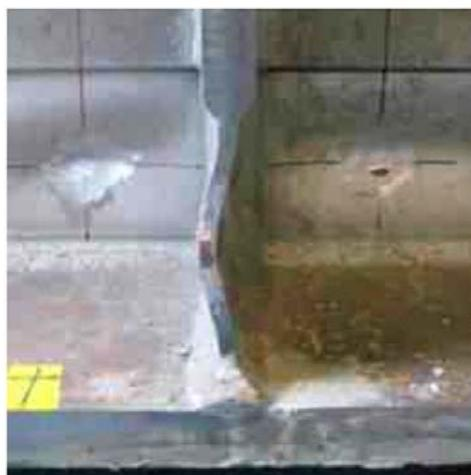
図 4-4-9 (b) 垂直補剛材の局部座屈
