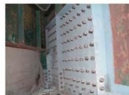
写真-4 けた端の当て板補強（緊急対策）
