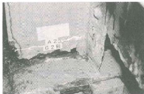
主桁端部の腐食損傷状況
