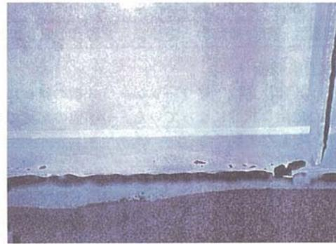
横桁下フランジの腐食状況
