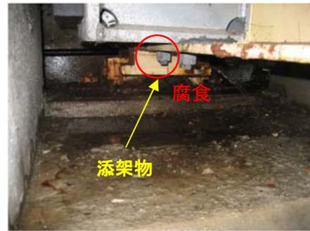
図 4-1-23 腐食した主桁がある桁端事例 2
