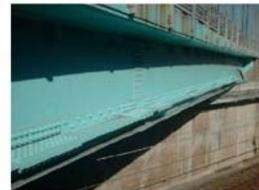
写真-5 主げた下フランジの補強
