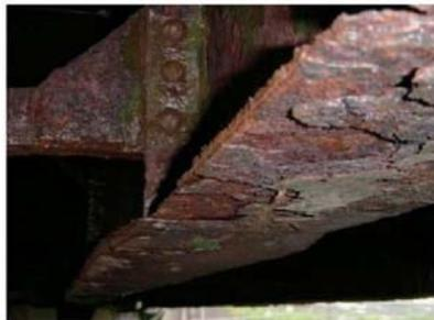
写真-2 主げた下フランジの腐食状況
