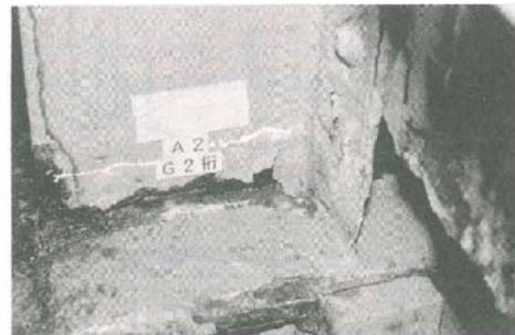
主桁端部の腐食損傷状況
