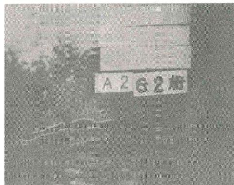
主桁端部の腐食損傷状況
