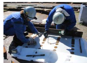
図-4 ウェブ板厚測定状況
