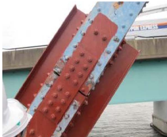
図 2-28 センターホールジャッキによる斜材の固定状況 4)
