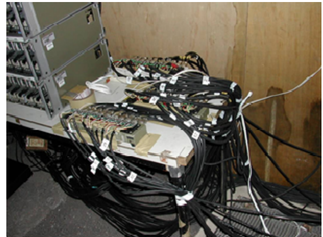
(b) ケーブル結線・配線状況
