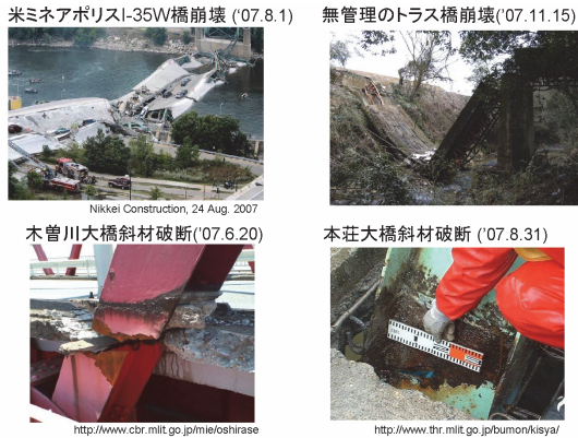
図 2-66 最近のトラス橋の重大損傷事例
