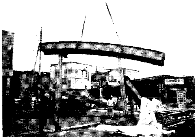
[写真-4.18：アーチリブの撤去(2)]
