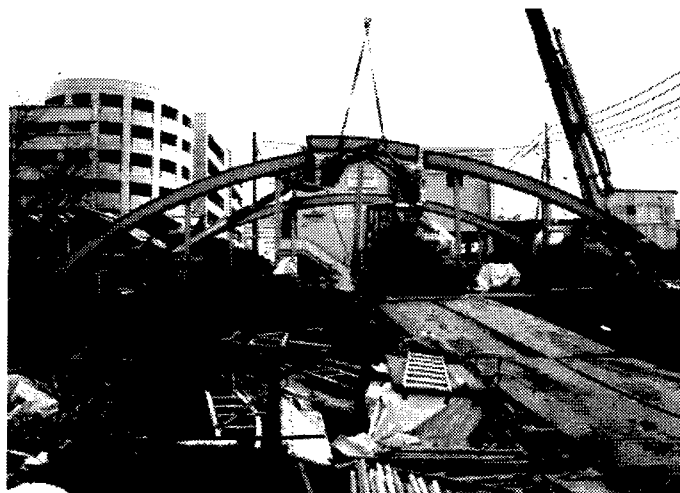
[写真-4.17：アーチリブの撤去(1)]
