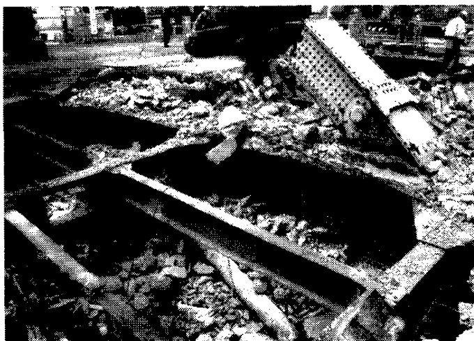
[写真-4.24：歩道部の床組]
