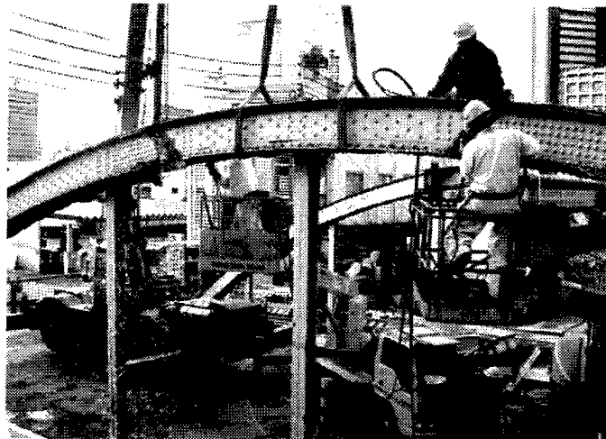
[写真-4.16：アーチリブの切断]
