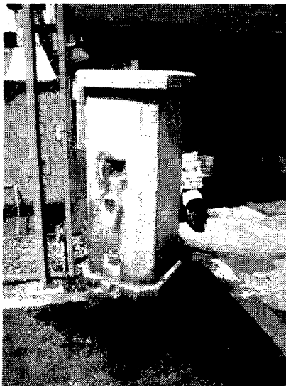
[写真-4.30：上流側左岸親柱]
