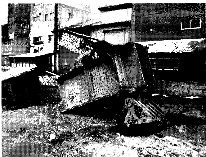
[写真-4.26：撤去された補剛桁端部]
