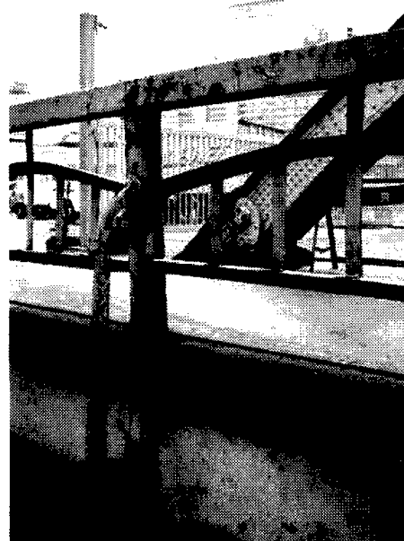
[写真-4.11：高欄と控え材]
