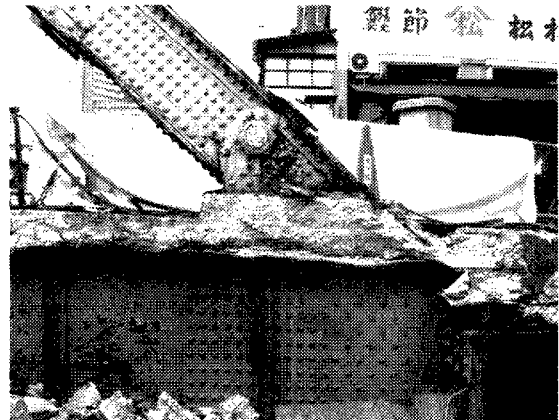
[写真-4.6：床版撤去後のヒンジ部]
