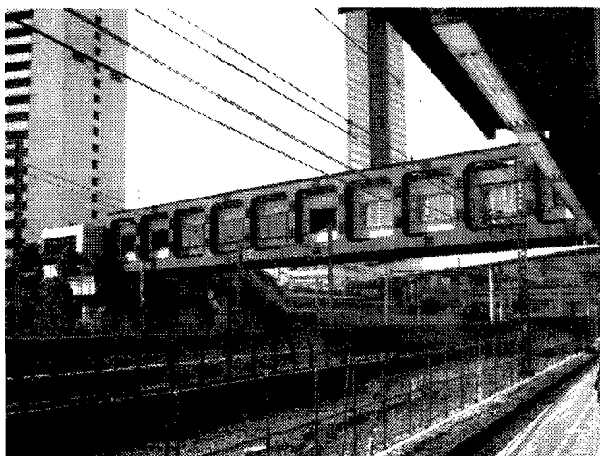
[写真-3.7.23：浜松町駅跨線人道橋]
