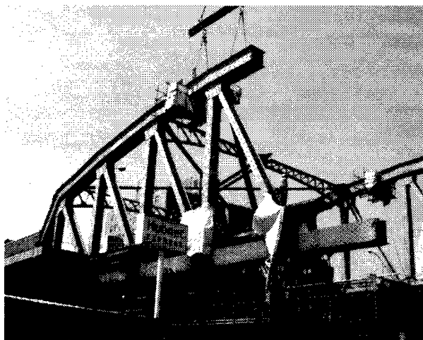
[写真-3.5.19：解体中の全景]
