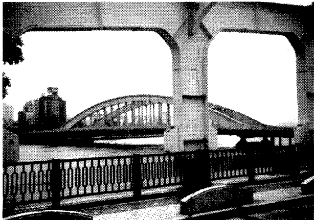
[写真-3.6.3：豊海橋から視る永代橋]
