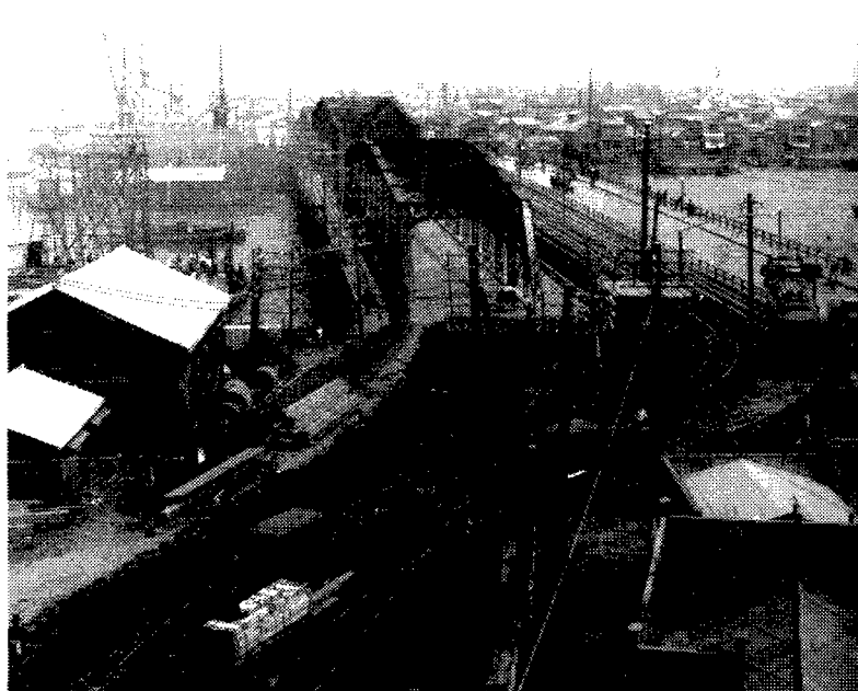
[写真-3.6.5:旧橋と新橋架設 16) ]
