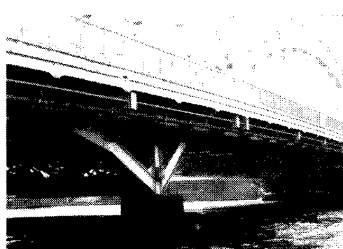
【写真-3.3.8：白鬚橋の支点部】
