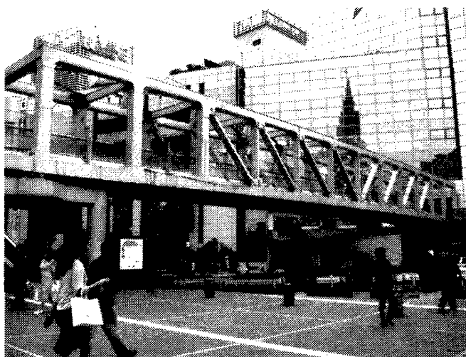
〔写真-3.7.30：甲州街道横断橋〕
