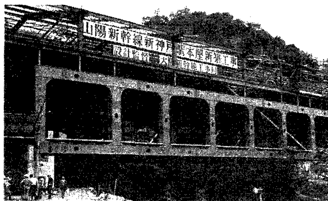
〔写真・3.7.21：新神戸駅ホーム桁 10) 〕
