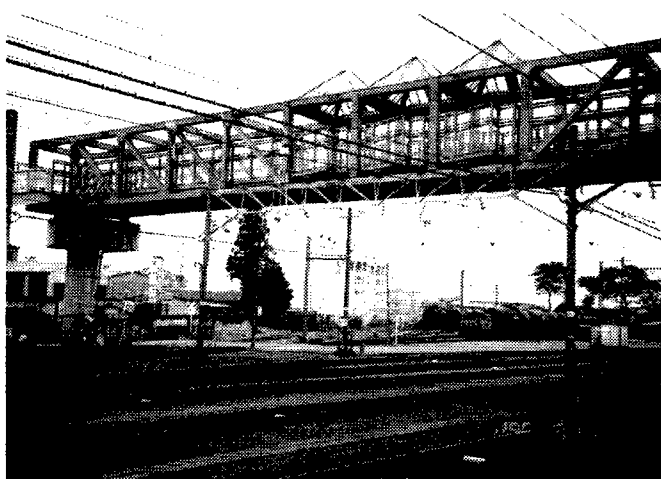
[写真-3.7.26：渋谷駅東西連絡橋]
