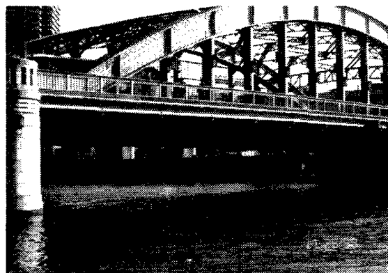
[写真-3.3.14：駒形橋の横桁]
