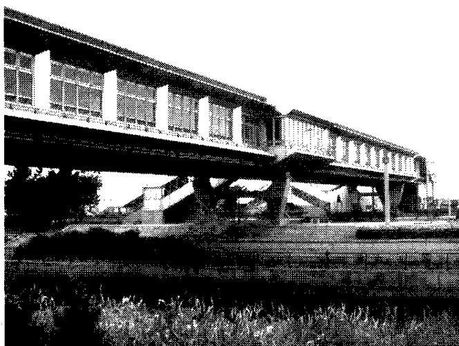
[写真-3.7.24：幕張メッセ駐車場連絡デッキ]
