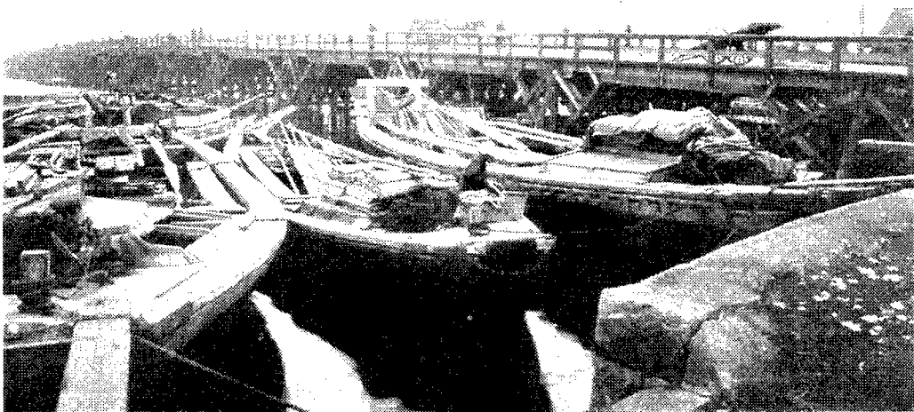
[写真-3.3.2：木橋時代の旧橋 17) ]
