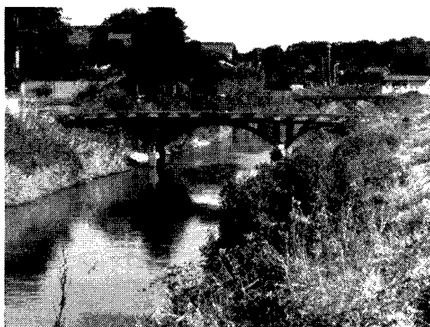
[写真-3.2.15：3 径間アーチ橋群]
