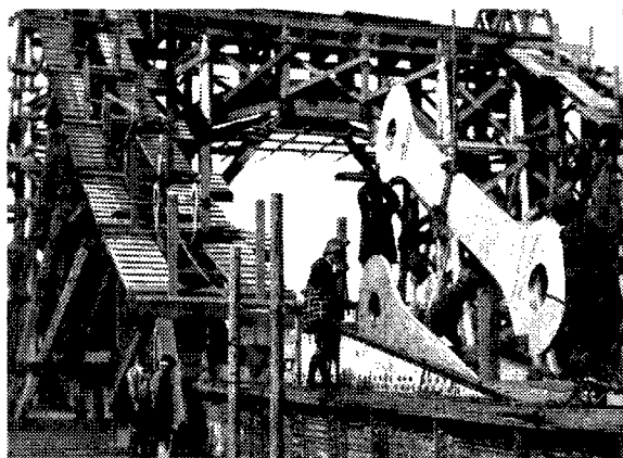
[写真-3.8.5：架設中の清洲橋 5) ]
