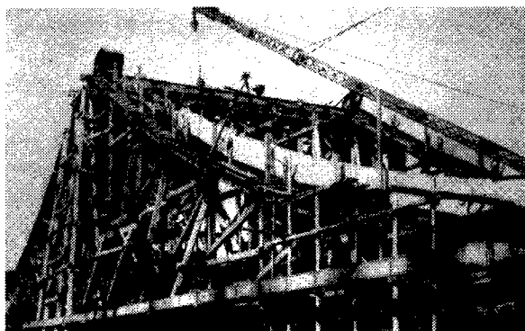
[写真-3.8.4：架設中の清洲橋 4) ]
